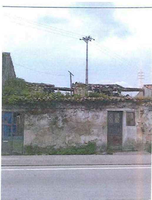
Imagem 1 – Foto onde é visível o colapso parcial da cobertura.
